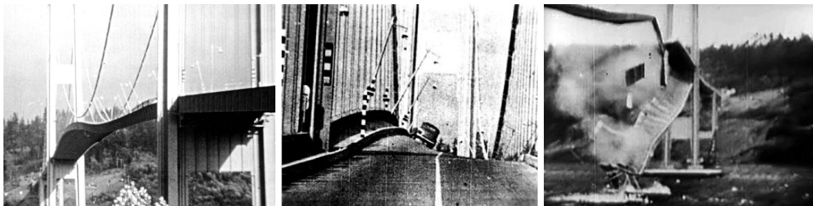
Abbildung 4: Der Einsturz der Tacoma Narrows Bridge: Windturbulenzen an der Brücke regten diese zum Schwingen in ihrer ersten Oberfrequenz der Torsionsschwingung (1 Knotenpunkt in der Mitte) an.
