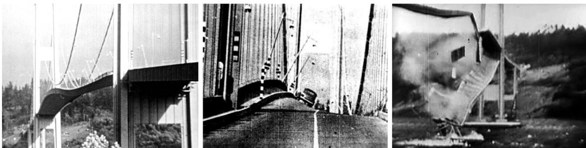
Abbildung 10: Der Einsturz der Tacoma Narrows Bridge: Windturbulenzen an der Brücke regten diese zum Schwingen in ihrer ersten Oberschwingung der Torsionsschwingung (1 Knotenpunkt in der Mitte) an.
